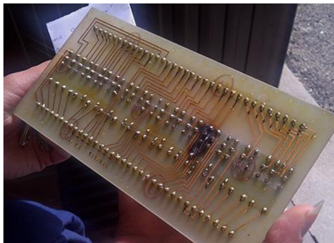
Un pequeño circuito eléctrico "quemado" causa el caos
